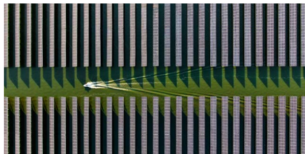
上海能源公司新能源示范基地一期工程
