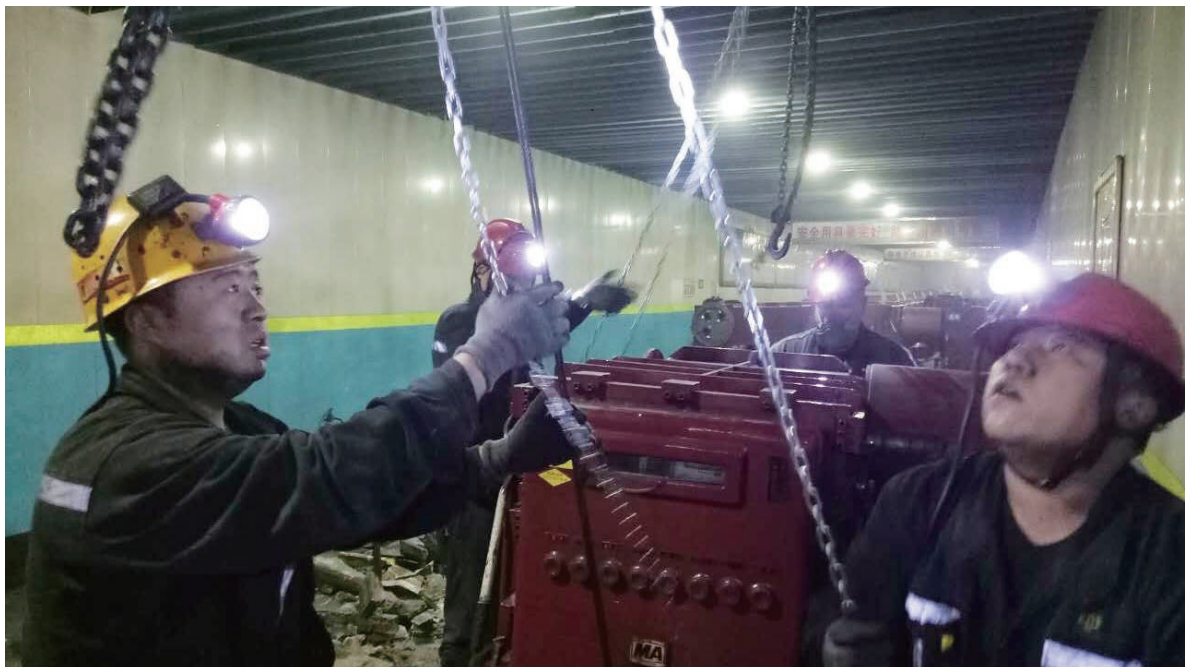
平朔井工二矿设备回撤
