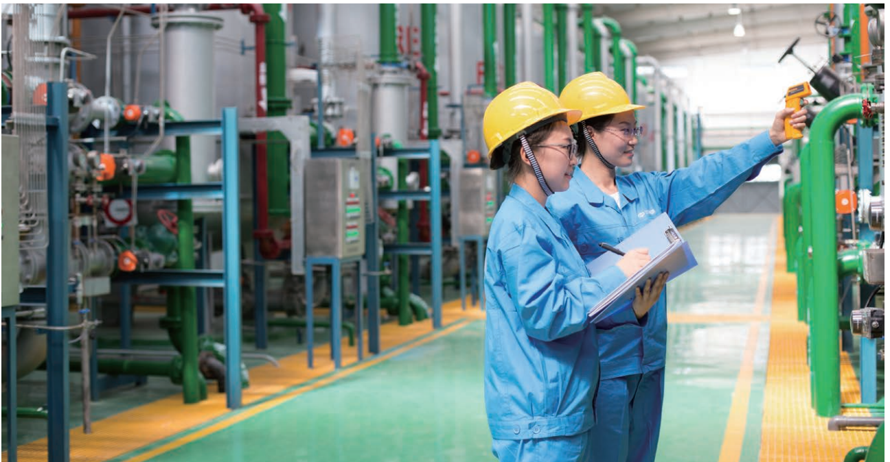
煤化工现场培训
